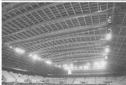
工事は8割方完成している
